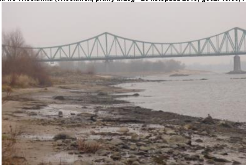
Kilkunastometrowej szerokości strefy dna rzeki podlegające sztucznemu odsłonięciu we Włocławku (Włocławek, prawy brzeg - 23 listopada 2018; godz. 14:25, Piotr Klonowski)
