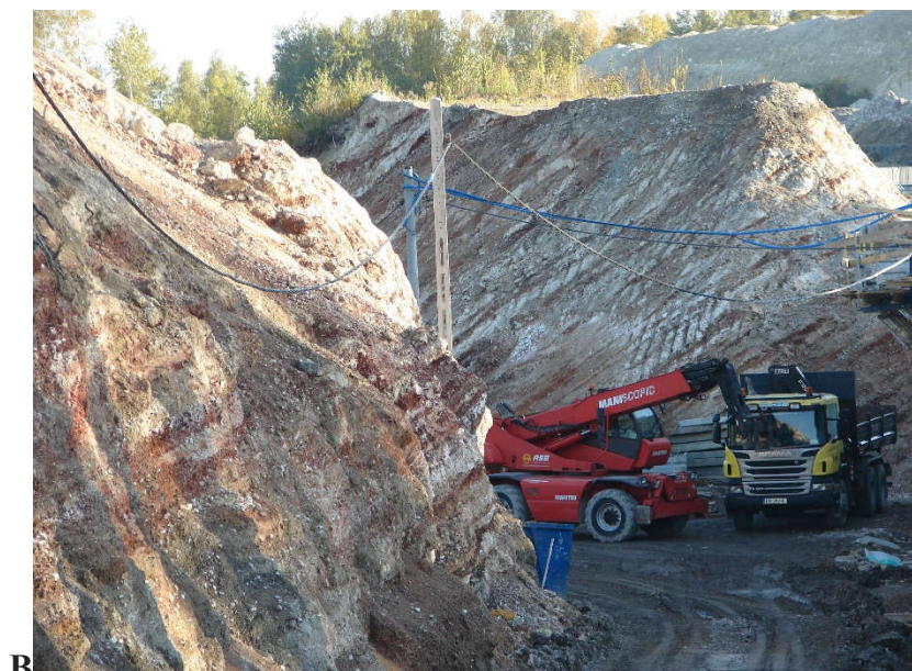
Fot. 2a i 2b. Realizacja inwestycji wymagała naruszenia bryły odpadów Krakowskich Zakładów Sodowych Solvay
