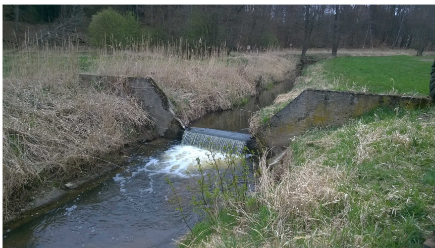
Stopień betonowy kilkadziesiąt metrów powyżej ujścia Wrzesinki
