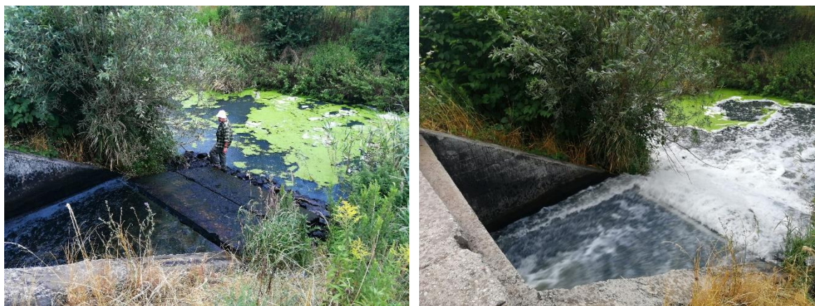
A B Fot. 2. Punkt opróbowania P9 – wylot kanalizacji zrzucającej zanieczyszczone wody do Kochłówki, z których część trafia do zalewiska. A- widok przy braku zrzutu ścieków, B – podczas zrzutu ścieków.
