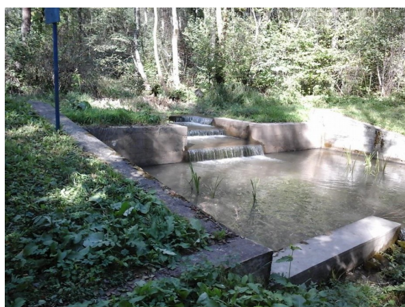
Rys. 17. Stały stopień spiętrzający oraz przepławka. (autor fot.: P. Skwara)
