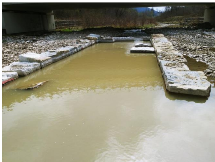
Rys. 6. Zmącenie wody w Śnietnicy dolnej spowodowane pracami na Śnietnicy górnej. 9 kwiecień 2019r.
