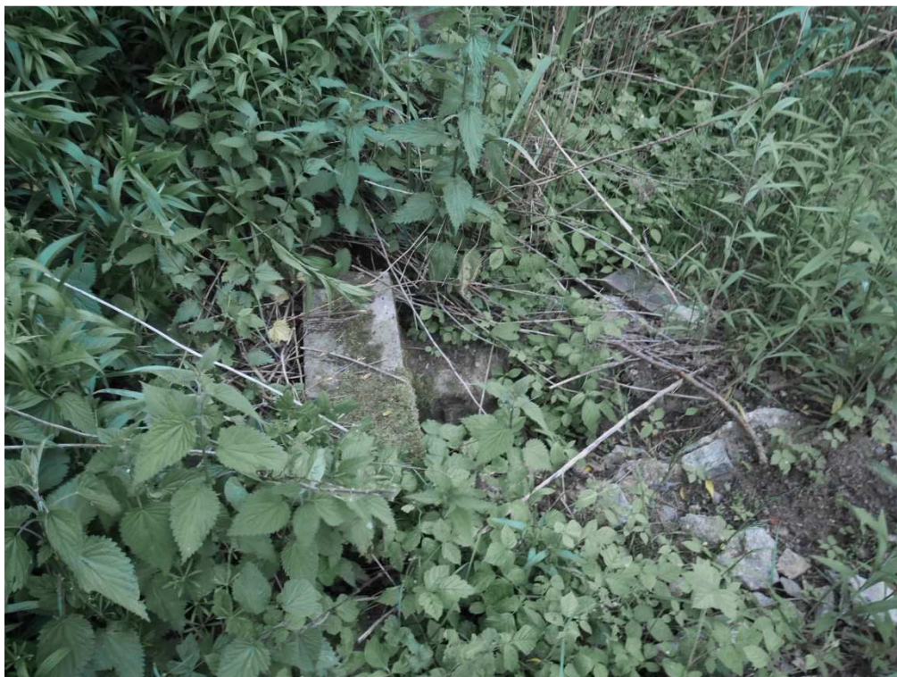
Fot. 9. Staw na dz. ew. 59/21. Widoczny zasypany mnich od strony północnej;
