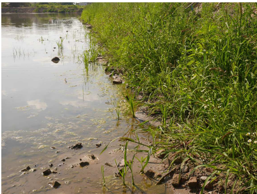
Fot. 5. Staw Duży na dz. ew. 59/20. Na brzegu widoczne cegły i kamienie z gruzu oraz porastanie skarp nowego stawu przez roślinność ruderalną;
