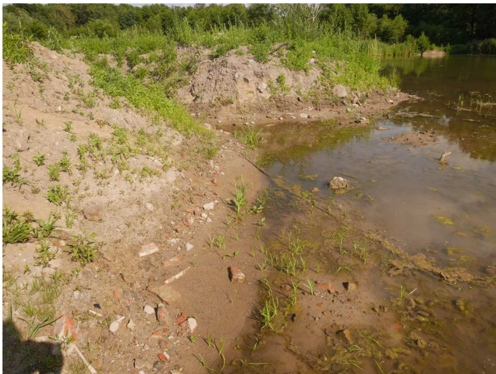
Fot. 4. Staw Duży na dz. ew. 59/20. Widoczne nieuksztaltowane, strome skarpy oraz elementy gruzu – odpadów budowlanych w humusie;
