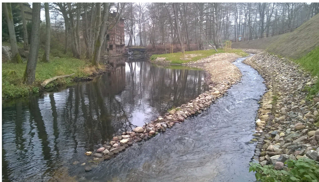
Stumetrowe, kręte koryto obejścia jazu w Głębocku, w sekwencji riffle & pool, wykonane wyłącznie z narzutów kamiennych i żwiru o ciągłym uziarnieniu.
