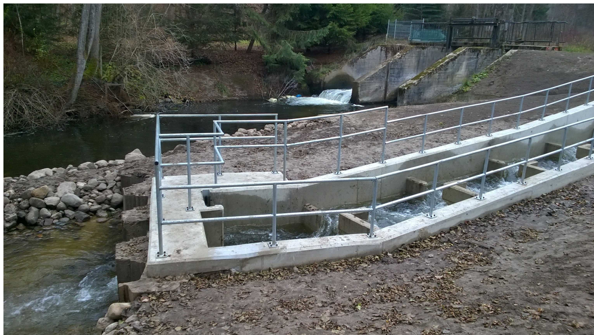
Przepławka szczelinowa na rzece Korytnicy w Sówce, szerokość szczeliny 0,30 m
