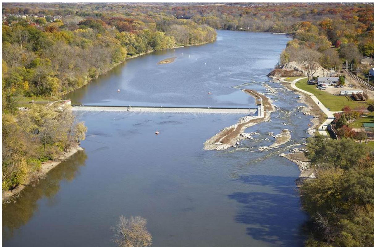
Rys. 19. Widok ogólny Glen D. Palmer Dam, FOX RIVER
