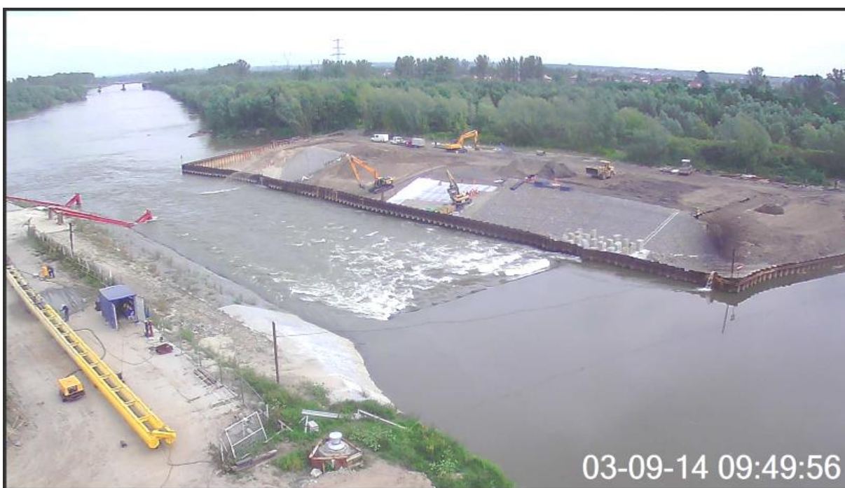
Rys. 12. Zasypywanie prawego brzegu.
