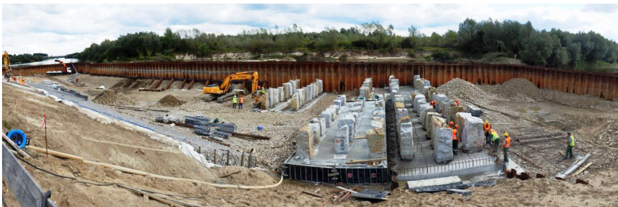
Rys. 11 Widok ogólny z etapu budowy. W tle prawy brzeg z widocznym szerokim naturalnym korytem rzeki.
