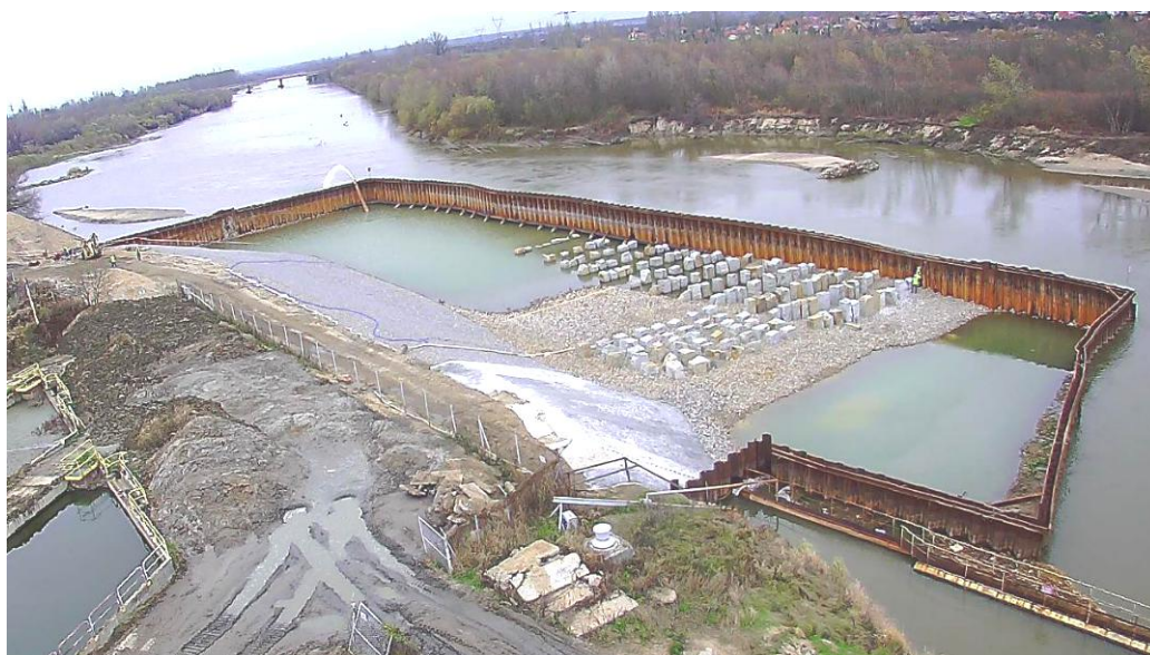
Rys. 10. Widok ogólny z etapu budowy. Na prawym brzegu widoczne szerokie naturalne koryto rzeki.
